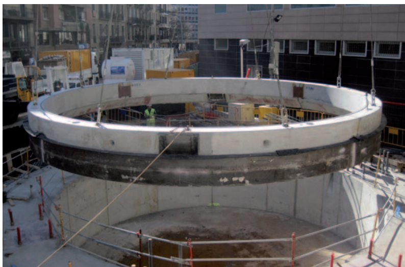
Fig. 5. Construcción y elevación de un anillo completo para colocarlo dentro del pozo/Assembly and lifting of a ring to be placed into the shaft.
