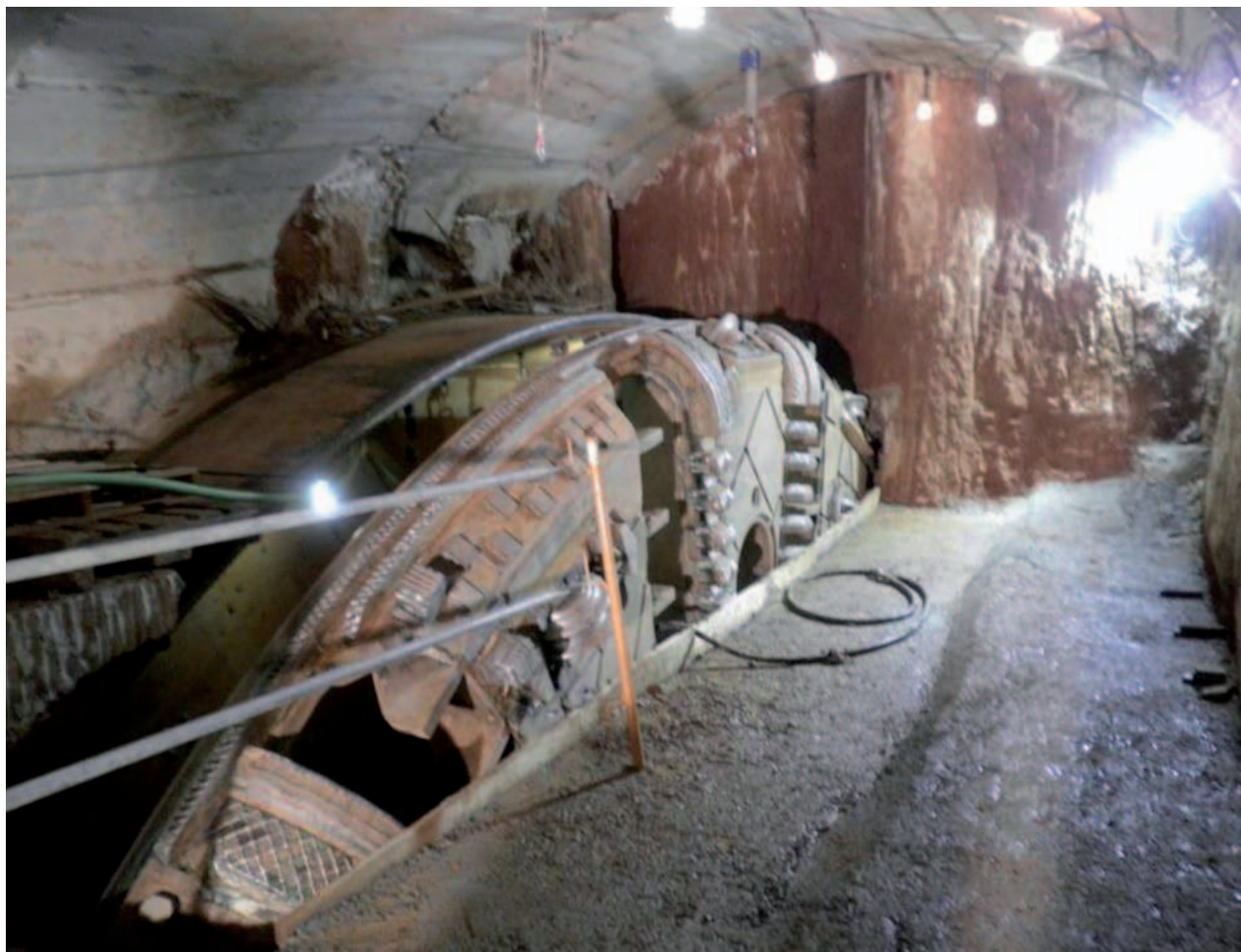
Fig. 19. Acceso por la galería para reparar la Rueda de corte de la TBM/ Access by the cross-cut to repair the TBM cutting head.
