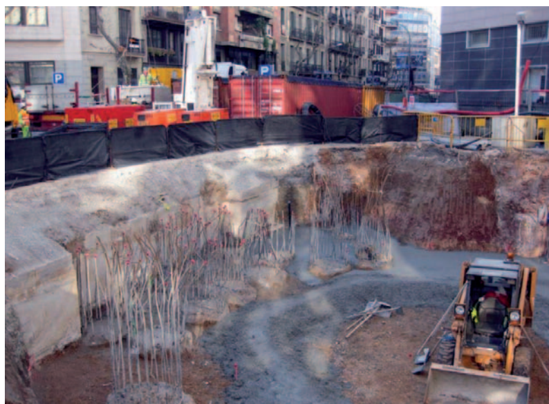
Fig. 1. Excavación inicial del pozo por métodos convencionales/Starting of shaft excavation by conventional methods.
