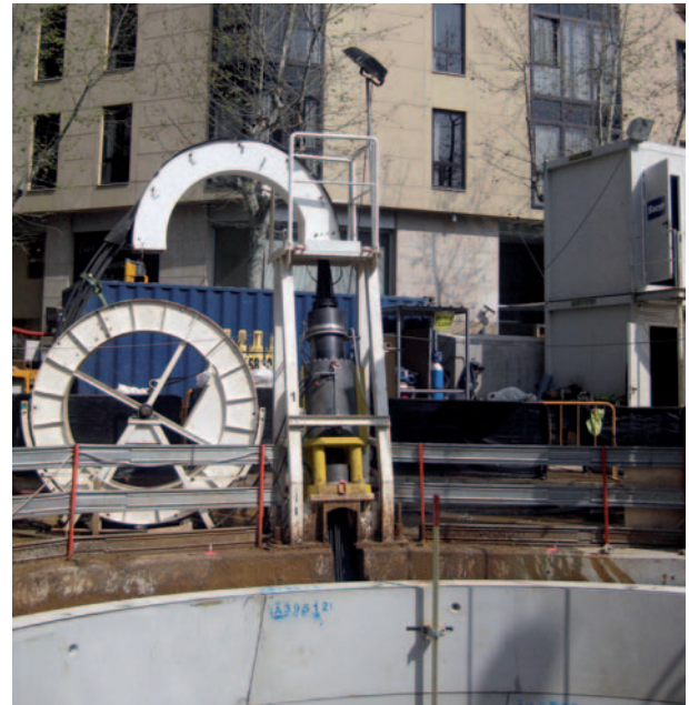
Fig. 12. Gato de retención/Strand jack.
