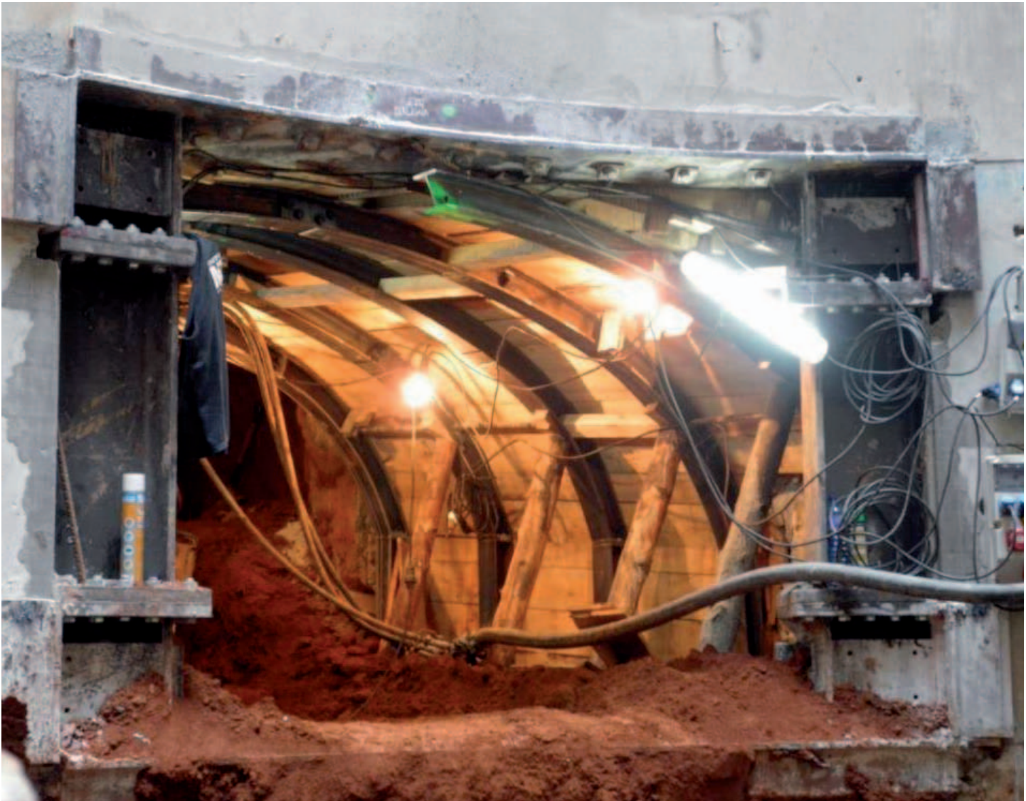
Fig. 18. Excavación de la galería transversal/Opening of the cross-cut.
