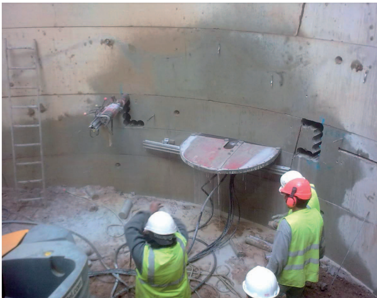
Fig.17. Corte del revestimiento con sierra de diamante/Lining cut by diamond saw.
