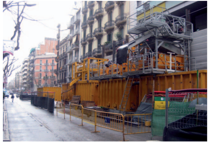
Fig. 8. Vista de la VSM dentro del pozo y de la "cadena" de los conductos de energía/View of the VSM inside the shaft and of the "tower" for the energy lines. A la derecha, fig. 9. Planta de separación/Right, Separation plant.
