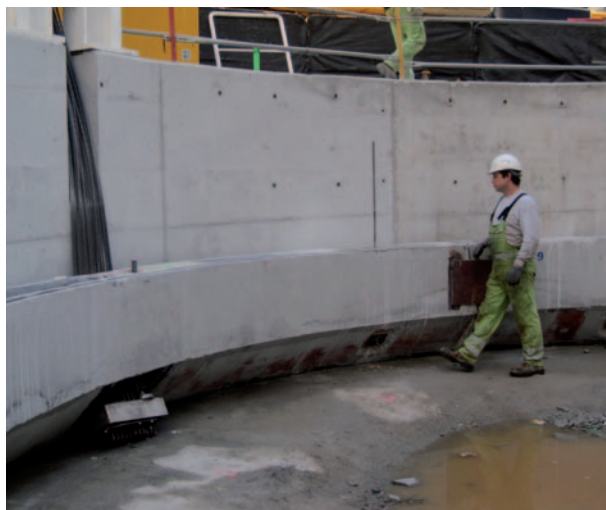
Fig. 6. Vista del borde cortante de acero a 45° del primer anillo y conexión de éste con los gatos de retención/View of the 45° steel cutting edge of the first ring and its connection to the strand jacks.
